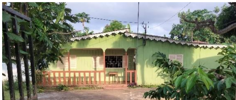
Habitação construída em madeira e zinco (cobertura)
